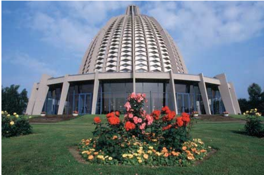
Casa de Adoración en Alemania
